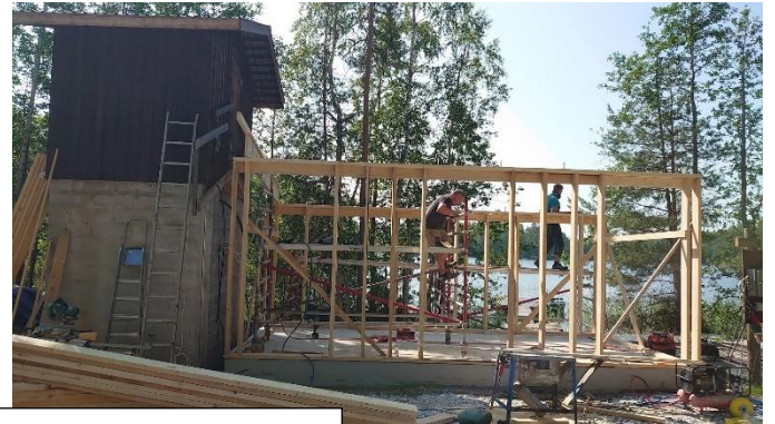
Kalamajan sosiaalityötilojen rungon, seinien ja katon rakentaminen.
