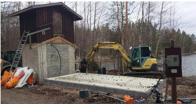
Kalamajan sosiaalitalan perustukset, lattialämmityskaapelit ja betonilattian valu
