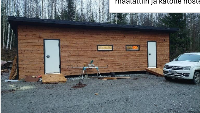
Kalankäsittelykontin seinät vuorattiin ulkolaudoilla, maalattiin ja katolle nostettiin pulpettikattorunko
